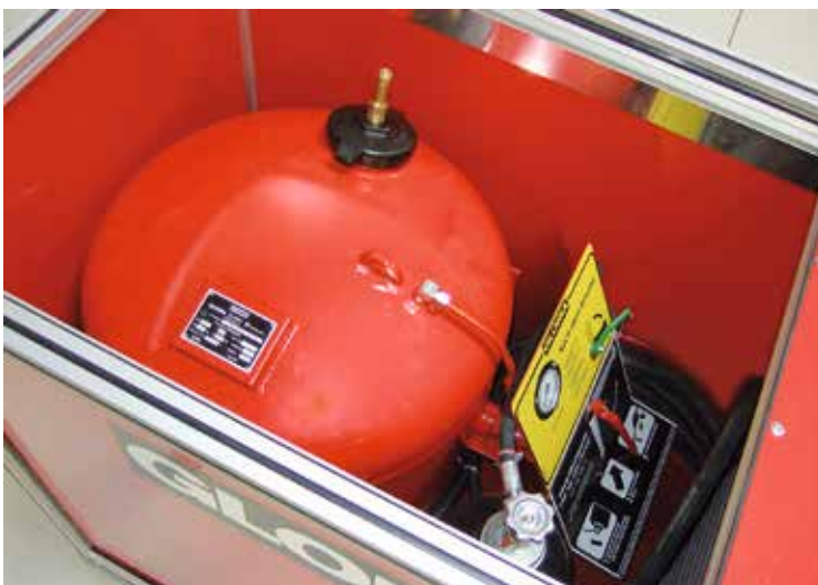
Feuerlöschcontainer von oben
