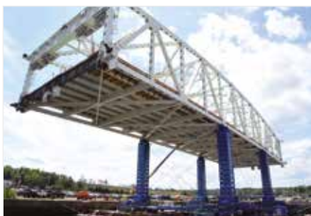
Levage progressif de pont
