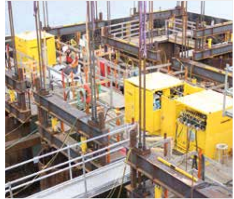
▲ Pompe hydraulique personnalisée pour un système de mise en place de tablier de pont.
