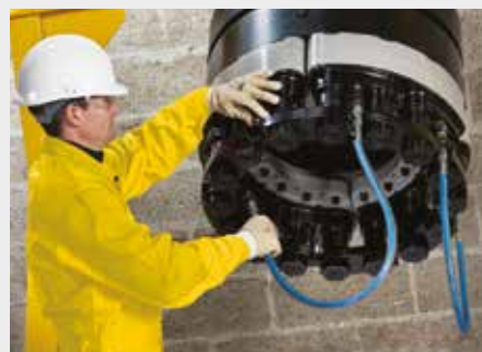
▲ Application de la mise en tension multigoujon
