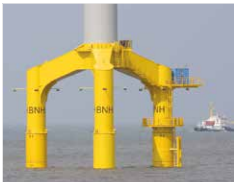
▲ Mise à niveau d'éoliennes offshore : Le système de levage synchronisé Enerpac a fourni la solution nécessaire pour niveler les traverses porteuses de 80 éoliennes.
