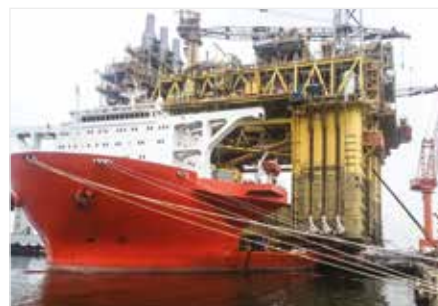
Super-levage et pose synchronisés
