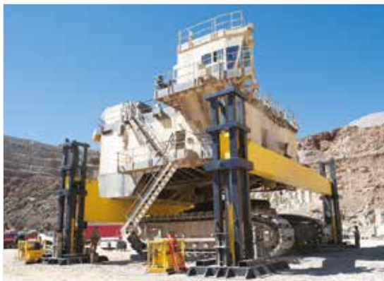
◀ Une pelle mécanique électrique de 1200 tonnes en cours de séparation à l'aide de vérins personnalisés de 500 tonnes de la série RR et d'un système de levage synchronisé de type une pompe par point.
